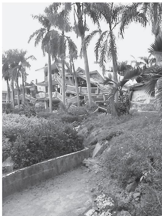
図1——1999年台湾中部(集集)地震において活断層直上で倒壊した校舎。
