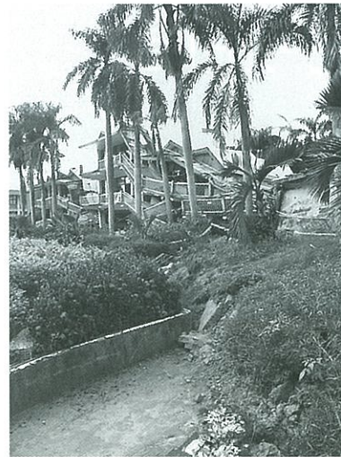
1999年台湾中部地震の地震断層(活断層)上で倒壊した校舎(台中市内)
