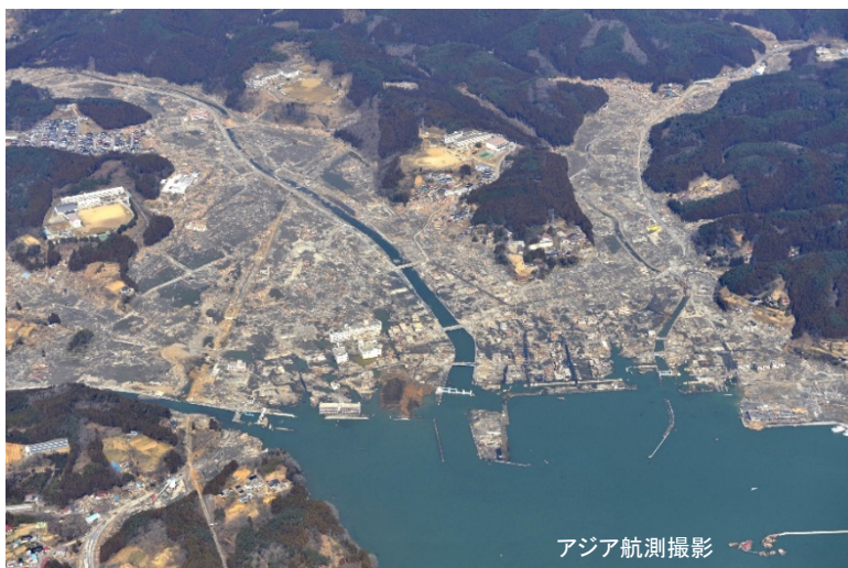
宮城県南三陸町(旧志津川町) Minami Sanriku, Miyagi Prefecture
